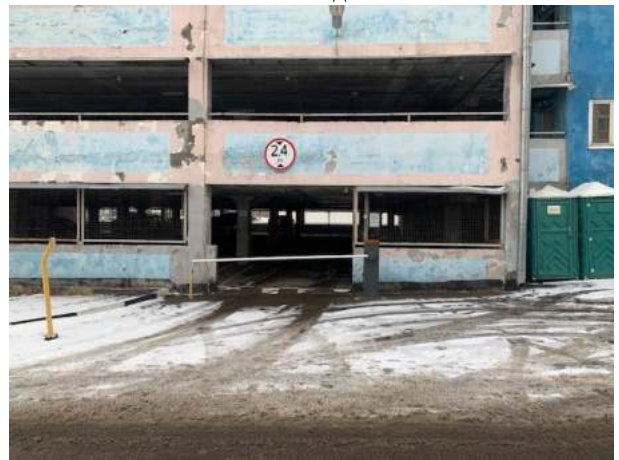
Въезд на территорию паркинга
