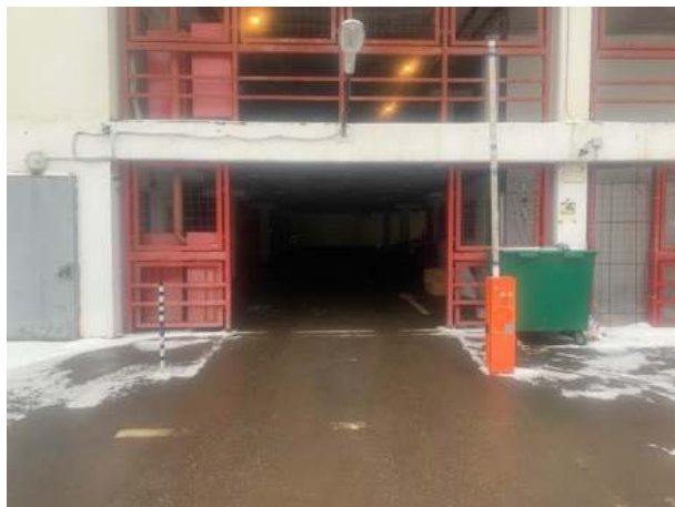
Въезд на территорию паркинга
