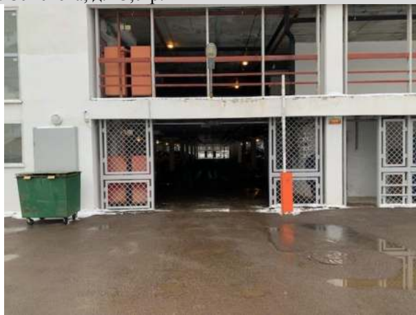
Въезд на территорию паркинга
