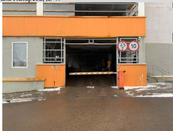
Въезд на территорию паркинга
