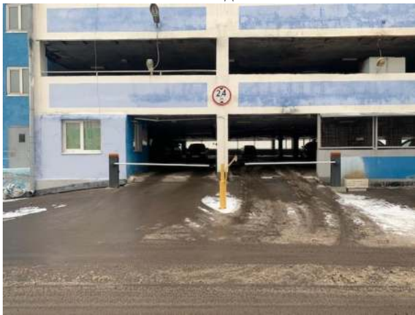
Въезд на территорию паркинга
