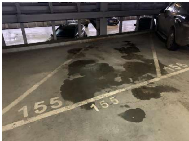
этаж 3 пом. IV, м/м 155
