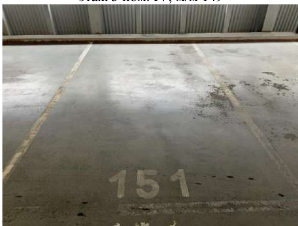
этаж 3 пом. IV, м/м 151
