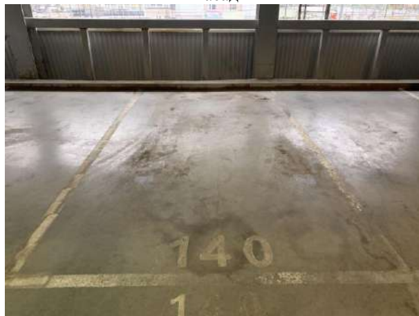
этаж 3 пом. IV, м/м 140
