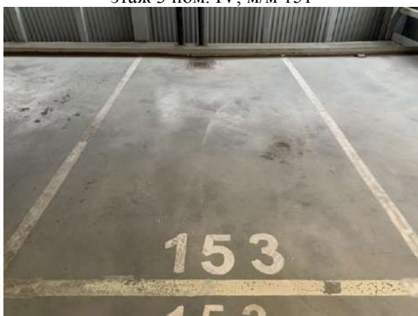
этаж 3 пом. IV, м/м 153
