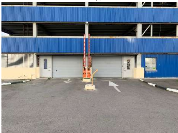
Въезд на территорию паркинга
