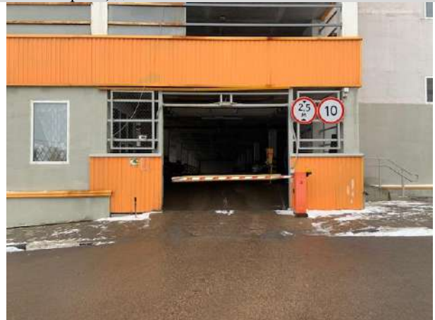
Въезд на территорию паркинга
